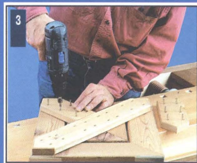
3 Диагональные элементы крепят снизу шурупами, используя электровинтовёрт.
